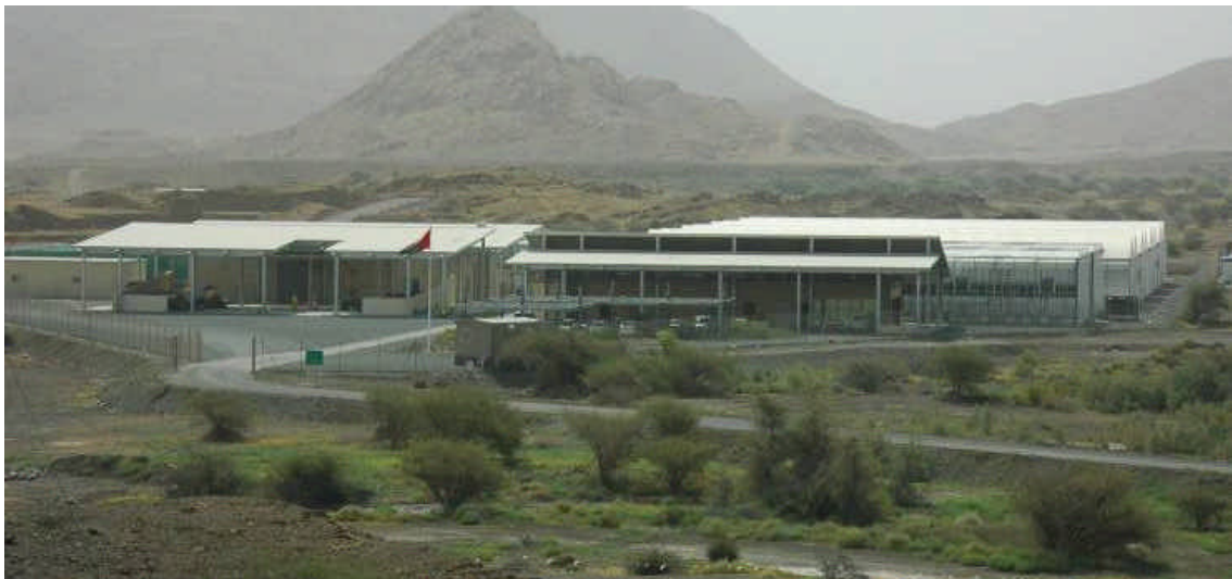
Abb. 3: Die Gärtnerei im Überblick. Der Komplex umfasst: Erdlager, Arbeitshalle, Anzuchthäuser, zwei Gewächshäuser, drei Folienhäuser, Schattenfläche. Foto: Tim Böhnert
